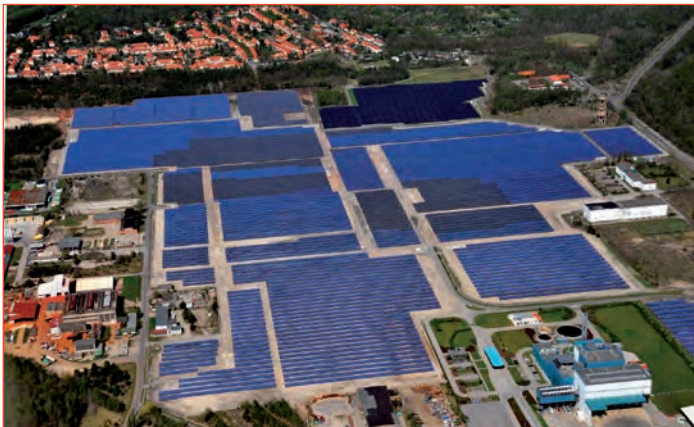
Wattner Solarkraftwerk Torno
